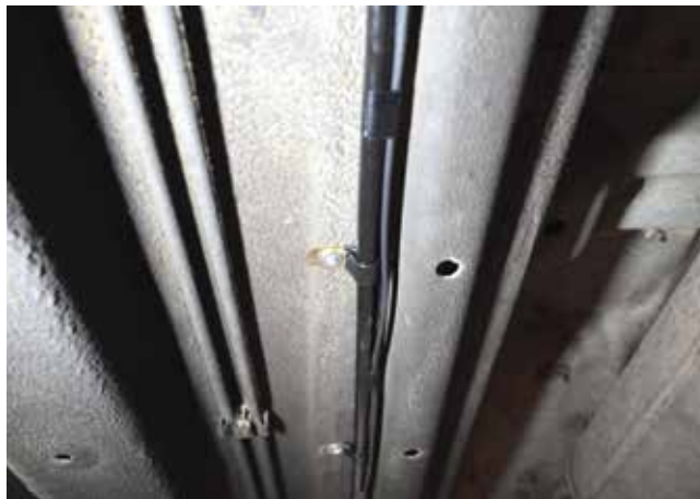
Rys.9 Przewód gazowy zamontowany na „blaszki” montażowe
